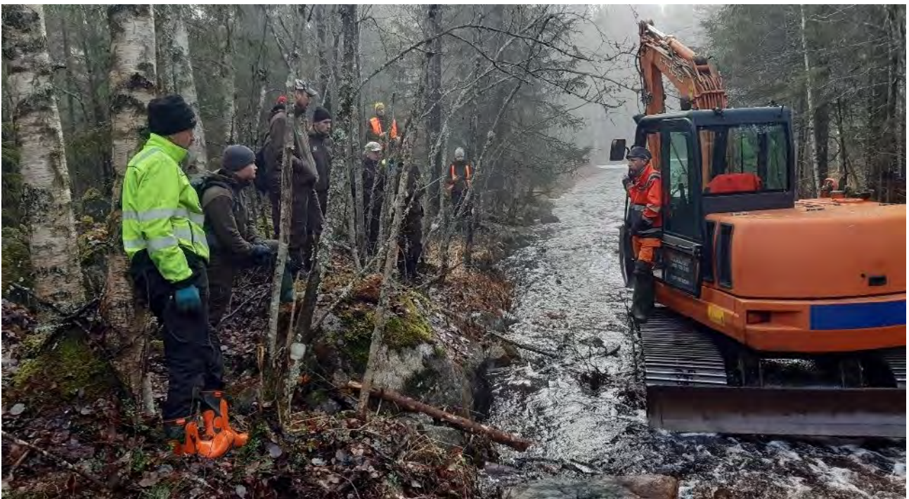
Kuva 8. Tutustuminen virtavesikunnostukseen, urakoitsija kertoo kunnostustoimenpiteistä- ja menetelmistä kaivinkoneella. Kuva: Jaakko Mattila.
