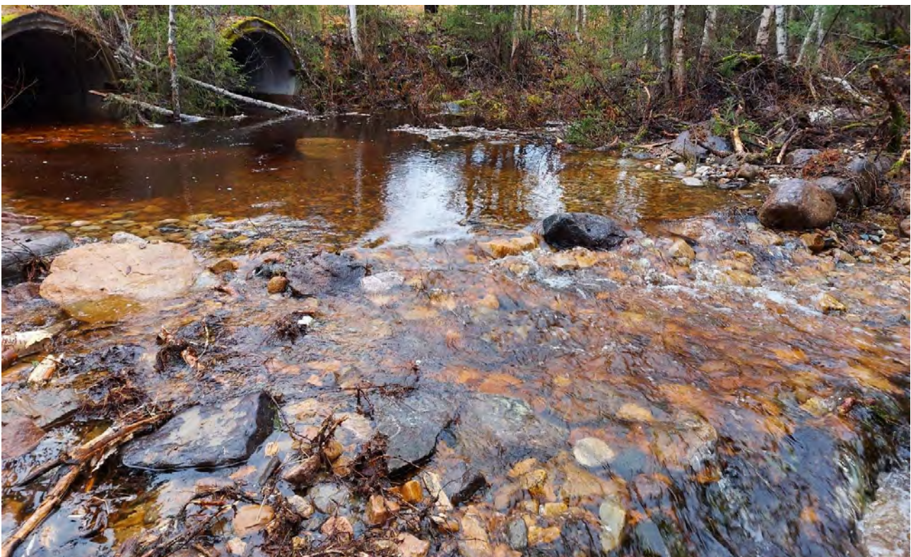
Vaellusesteenpoistoa kynnystämällä, kuva otettu työn ollessa kesken. Kuva: Joonas Fontell.
