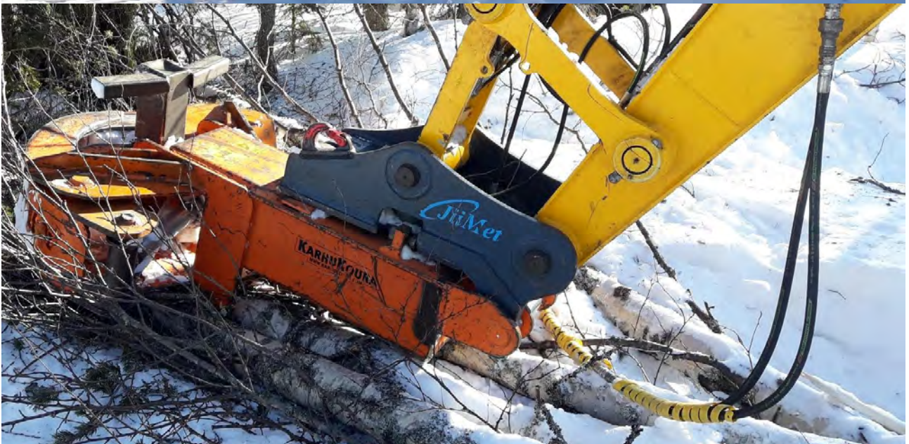
Kaivinkone poistamassa puita giljotiinikouralla Poika-Loukusan ojan valuma-alueella Taivalkoskella. Kuvat: Antti Karppinen
