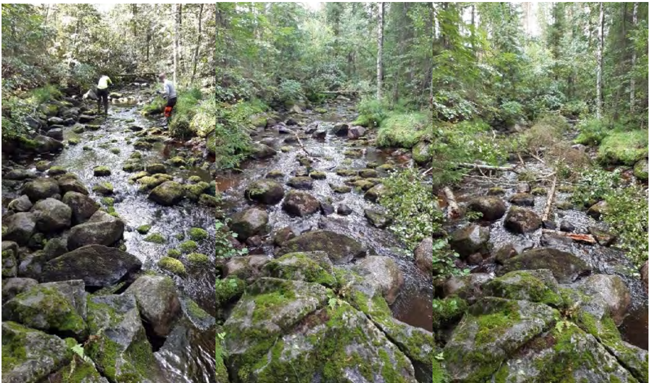
Kuvassa poikaskiveä levitetään kutusoraikon alapuolelle. Vasemmalla alkuperäinen uoma, keskellä vinssillä ja käsityönä kivettynä ja oikealla puumateriaalin lisäämisen jälkeen.
