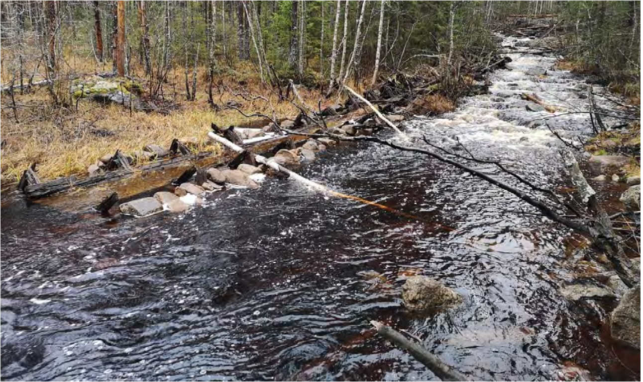
Osittain säilynyt puinen uittoränni Särkkäjoella. Ränniin liittynyt vaellusesteellisyyttä aiheuttanut säätopato purettiin kunnostustöiden yhteydessä.
