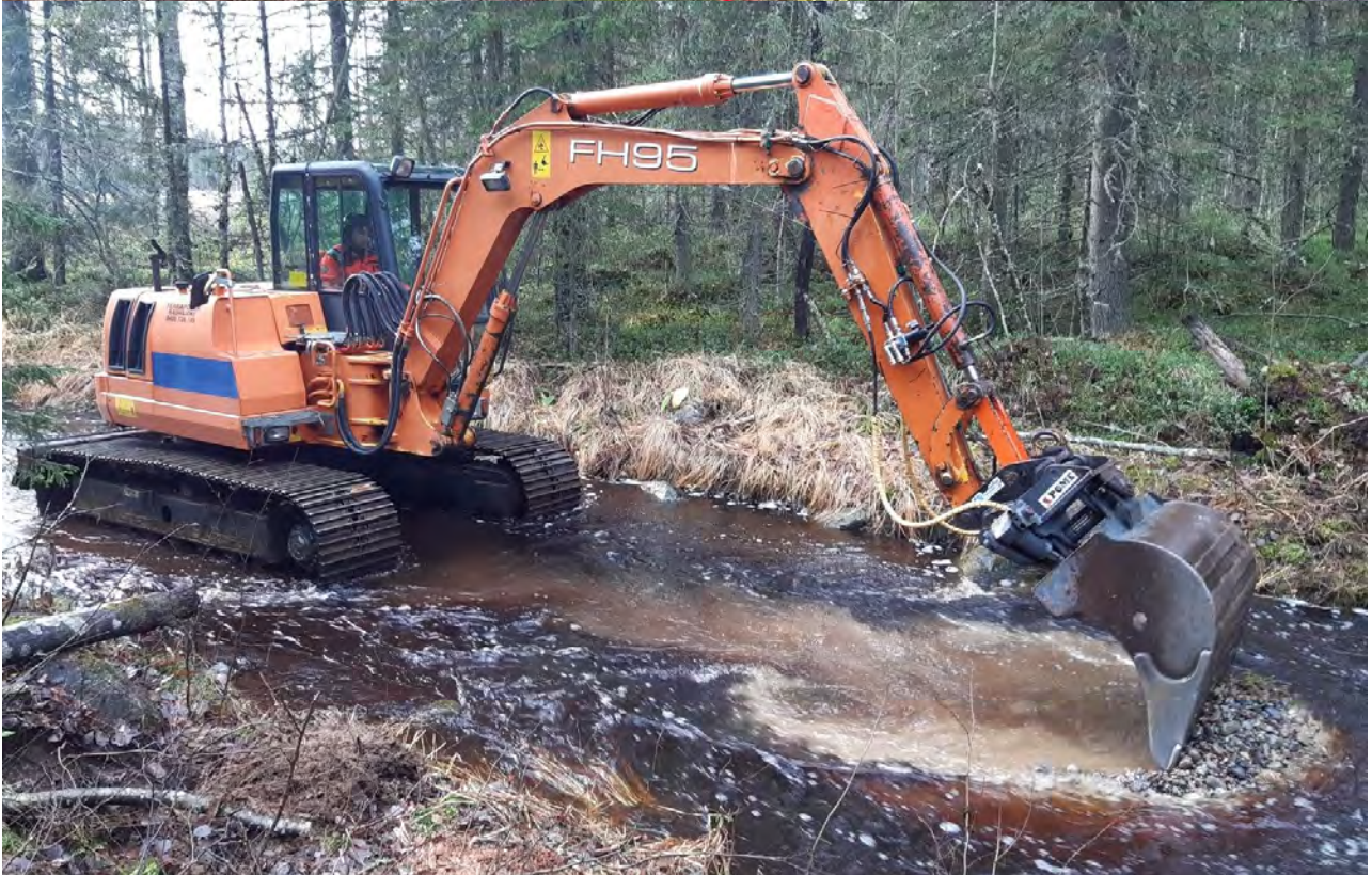
Tarvittavat sorat kuljetettiin uoman varrelle pienmetsäkoneella ja levitettiin oikeille paikoille kaivinkoneella.
