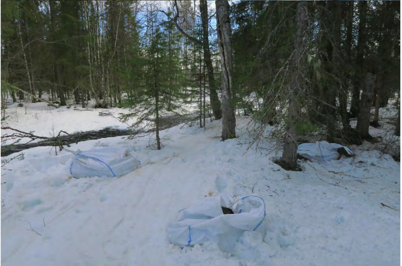
Silmäjoen varrelle kuljetettiin säkitettyä kutosoraa moottorikelkoilla.
