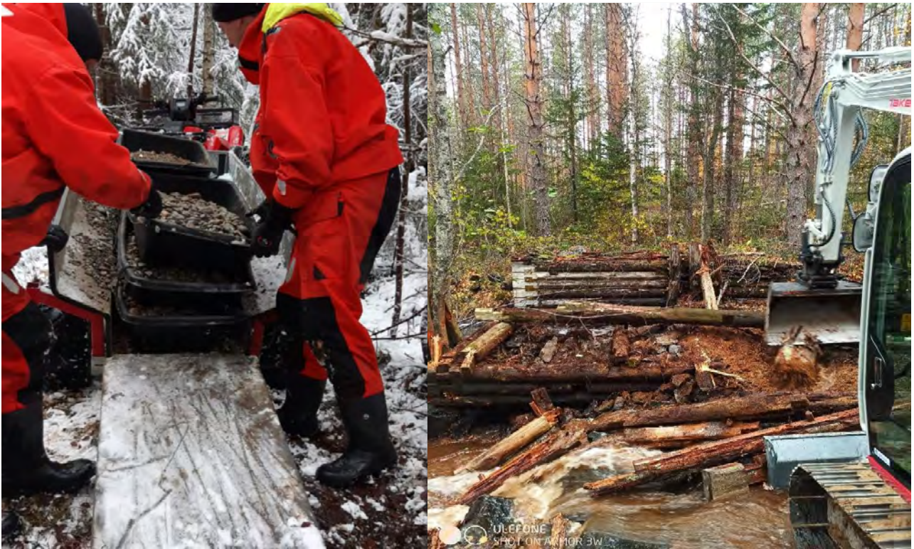
Kutusoran kuljetusta Myllypurolla ja patorakenteen purkua Särkkäjoella.
