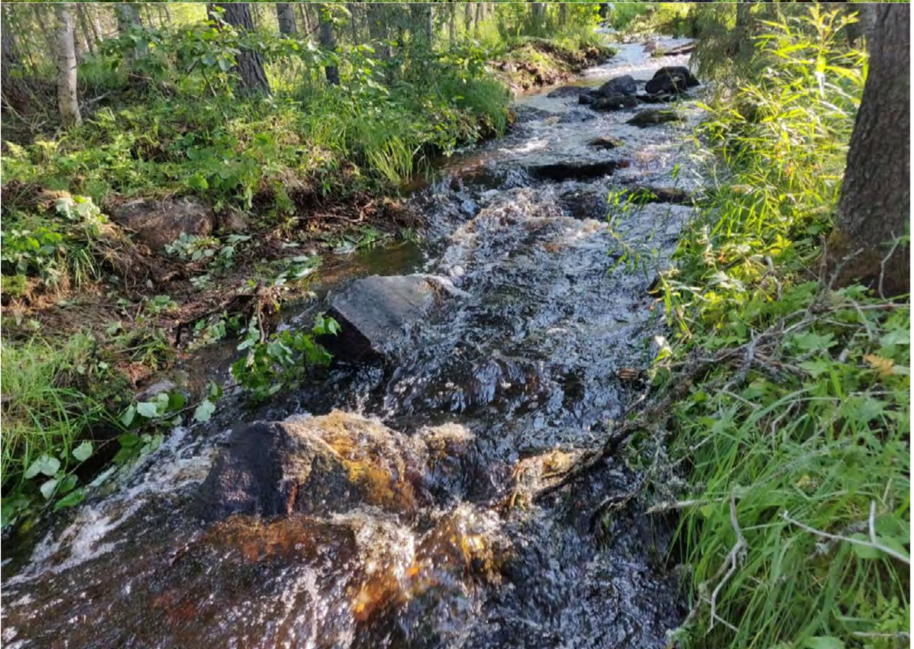
Kaivinkoneella kivettyä ja sorastettua Teeripuroa, puuta lisättiin uomaan kuvien oton jälkeen.
